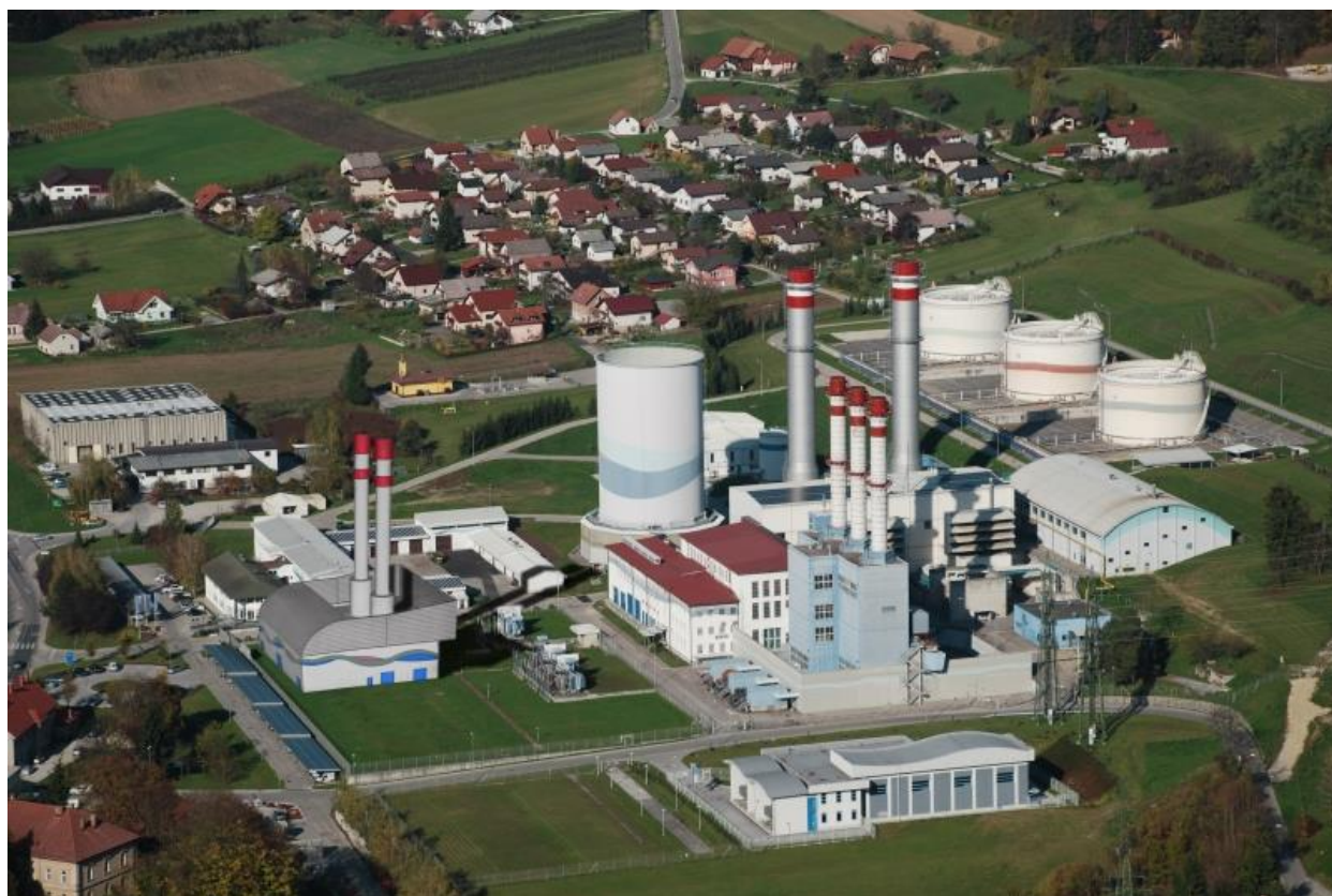
Na sliki: Plinska elektrarna Brestanica
