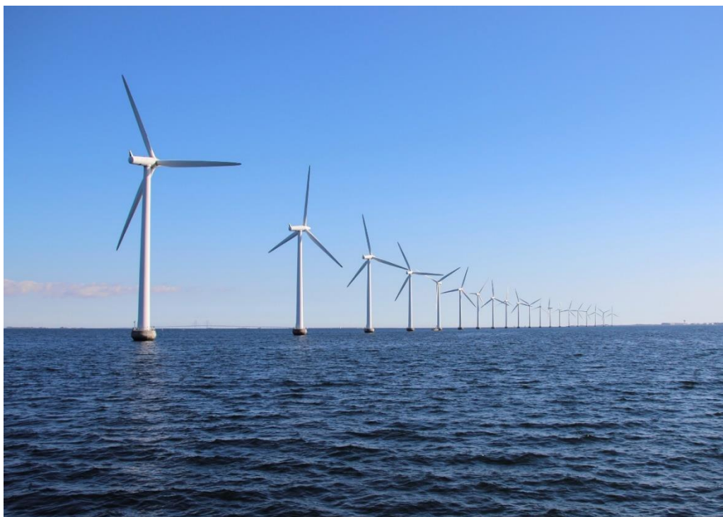
Na sliki: Polje vetrnih elektrarn na morju
